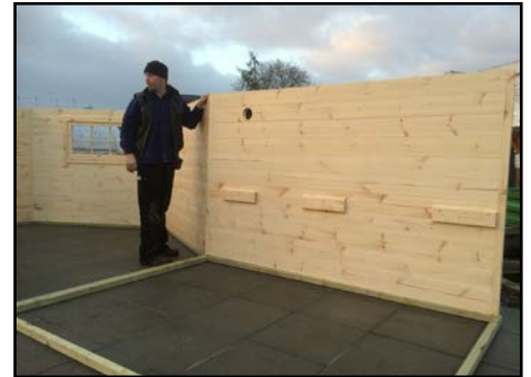
Wände auf Unterkonstruktion
