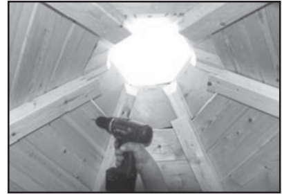
Dachhaube von innen mit Schrauben befestigen
