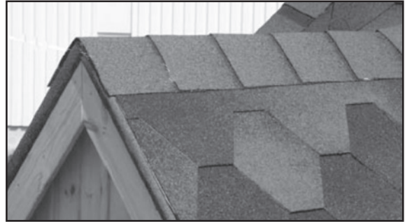
Schindel mit Dachpappennägel befestigen
